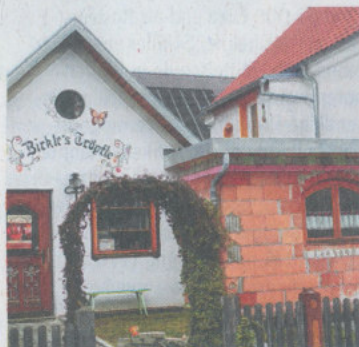
Der Anbau rechts neben dem Laden erhält noch eine passende Fassade.
